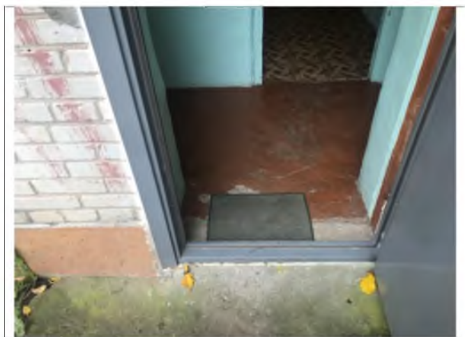
Фото №5 - Внешняя входная дверь
