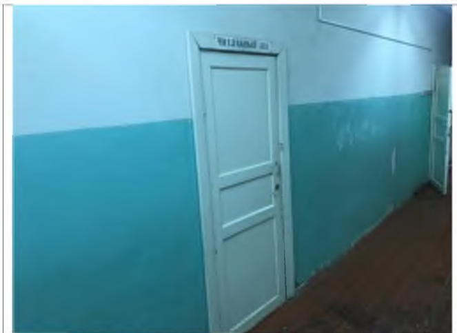
Фото №13 – Пути движения внутри здания (двери)
