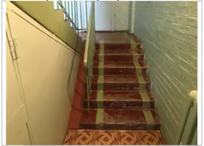
Фото №8 – Пути движения внутри здания (лестница)
