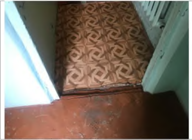
Фото №7 – Внутренняя входная дверь
