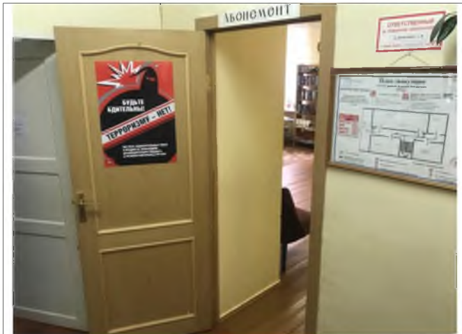
Фото №15 – Пути движения внутри здания (двери)
