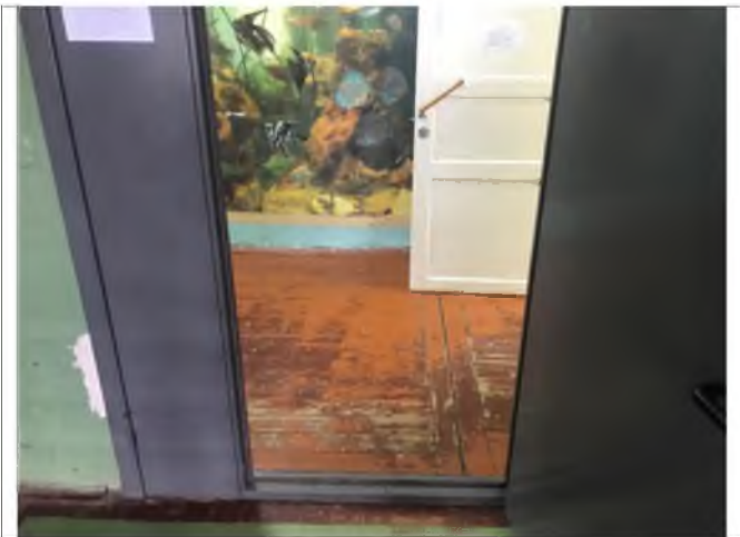
Фото №11 – Пути движения внутри здания (двери)
