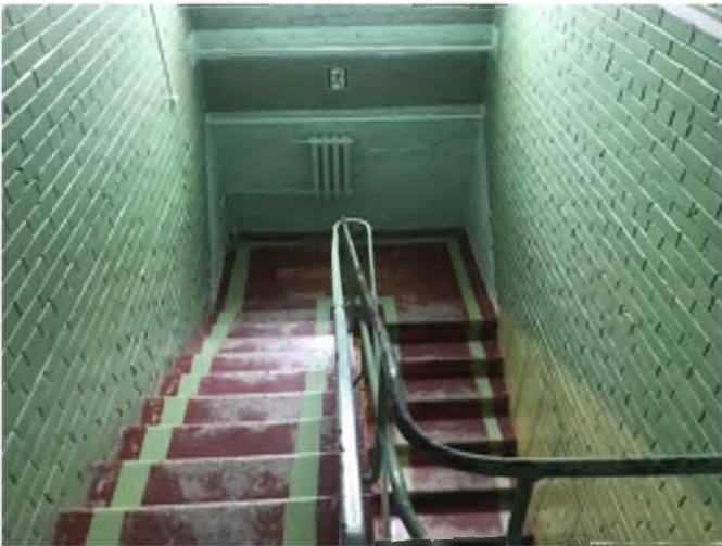
Фото №9 – Пути движения внутри здания (лестница)
